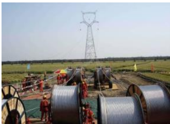
图 3.1-3 线路工程沿线牵张场布置形式照片
