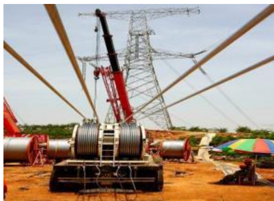
图 3.1-3 线路工程沿线牵张场布置形式照片
